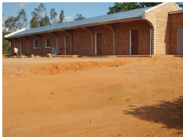
La laboratoire Plantes et Santé en construction
